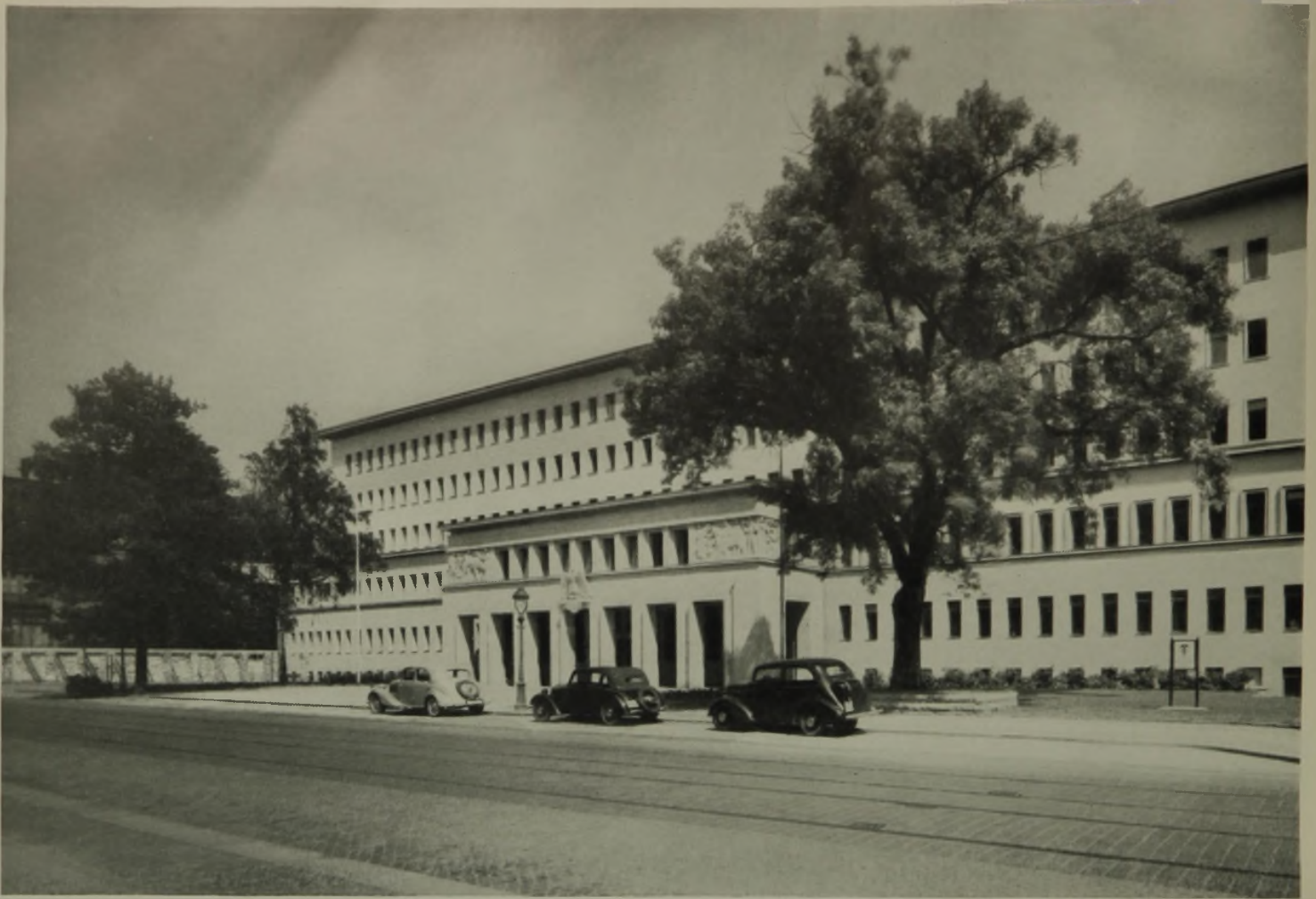
1 Gesamtansicht an der Ammonstraße in Dresden
