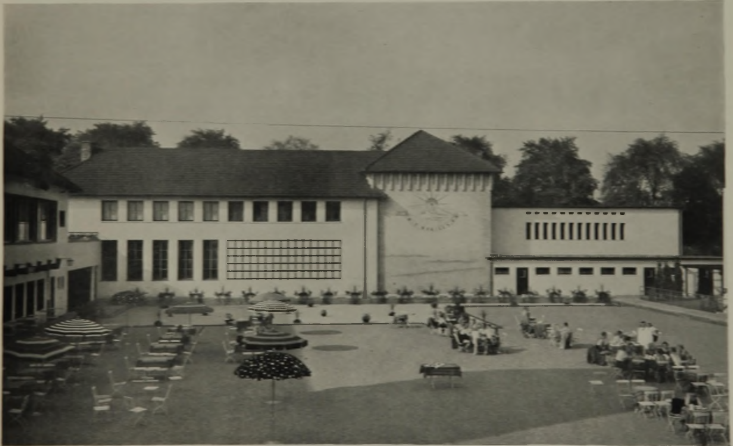
5 Blick über den Garten auf das Maschinenhaus mit dem turmartigen Solespeicher und dem anschließenden Filterhaus
