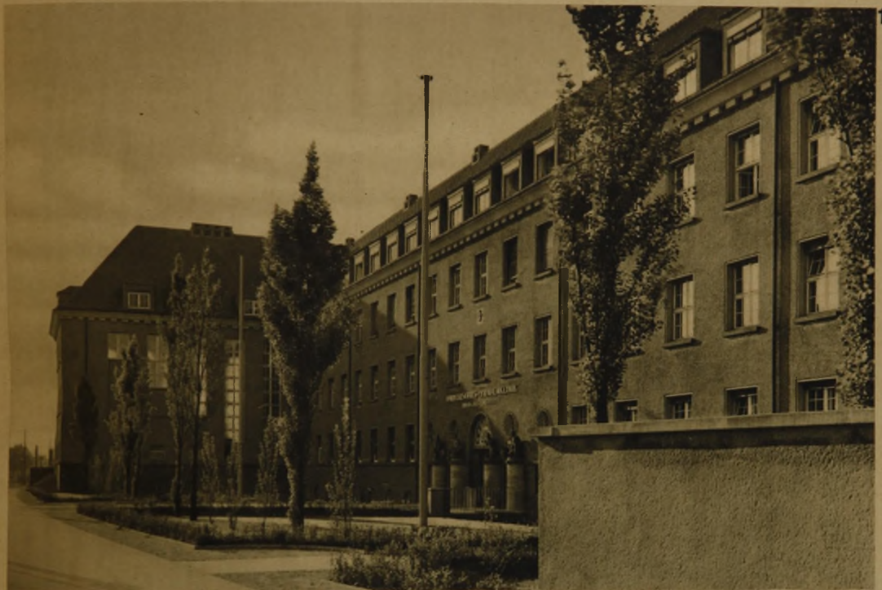
STRASSENANSICHT FLÜGEL A MIT HÖRSAALANBAU
