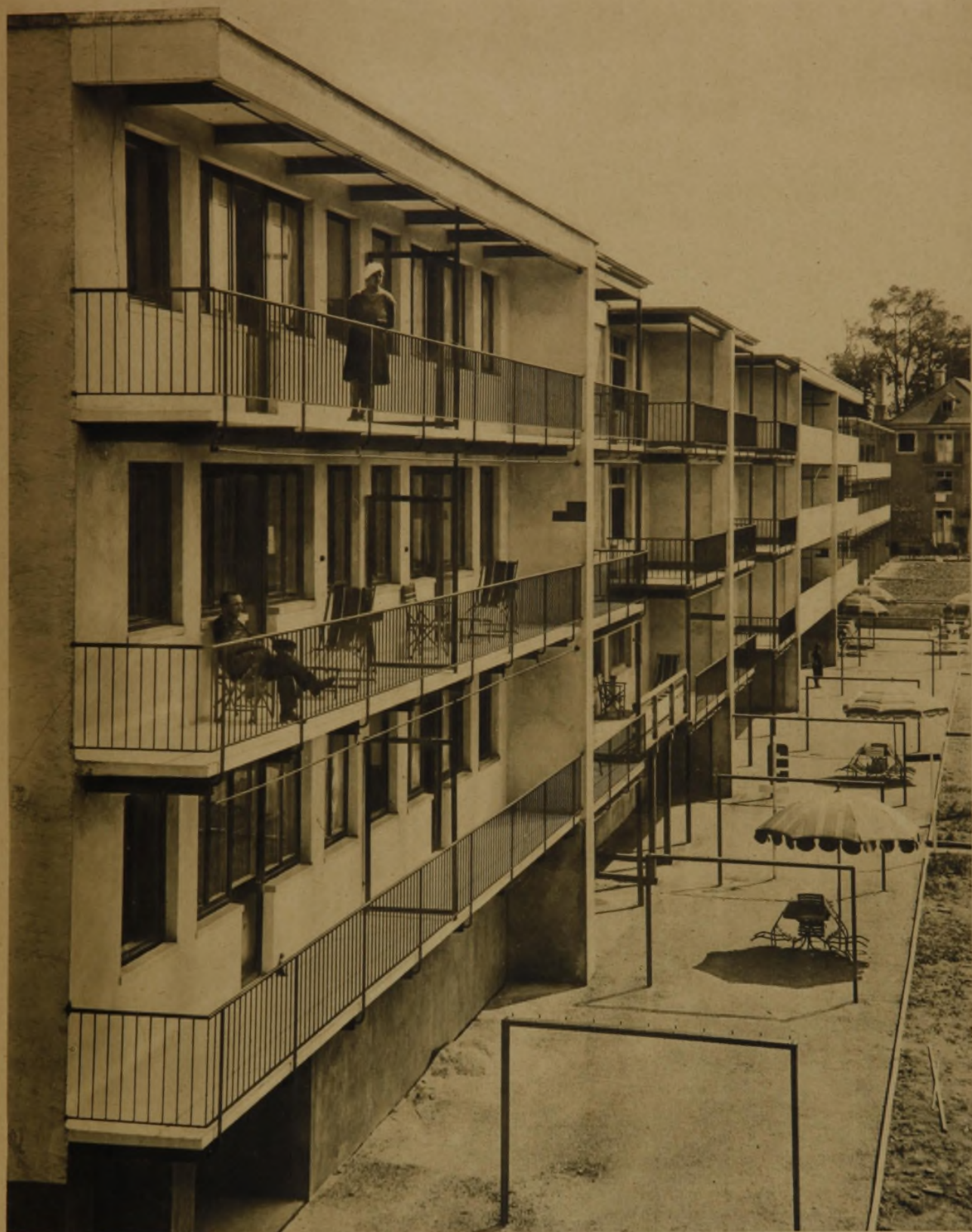
SIEDLUNG EGLISEE, MEHRFAMILIENHÄUSER ARCHITEKTEN DER HÄUSER LINKS: STEGER UND EGENDER, ZÜRICH
