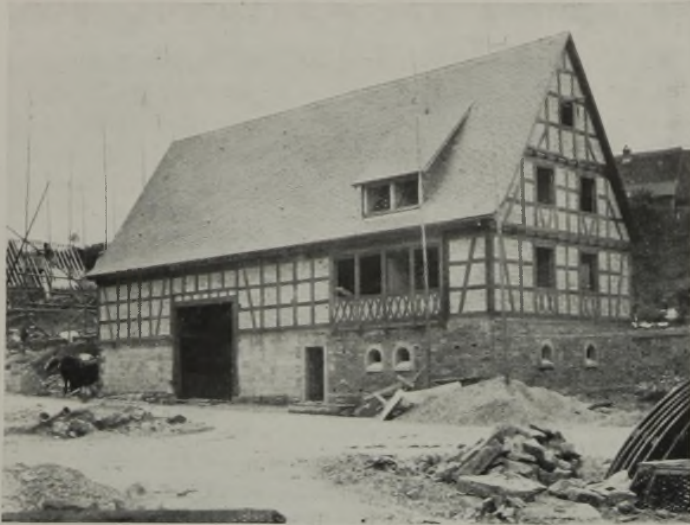
Abb. 11. Das Bauernhaus (Rohbau) zum zweiten Beispiel und zu Abb. 12—14 gehörig. Baukosten (ohne Bauplatz und Anliegerbeiträge) 22 200 RM.
