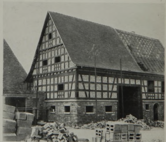
Abb. 16. Ansicht eines Wohnhauses mit Scheune und guter Wandeinteilung. Die Fachwerkfiguren als Heilszeichen der Giebelseite das Doppelkreuz = das feste Recht.
