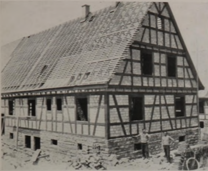
Abb. 17. Ansicht eines weiteren Bauernhauses (zu dem Grundriß in Abb. 18). Oben im Giebel versteckt das Heilszeichen der Mutter-Rune. — Baukosten (ohne Bauplatz und Anliegerbeiträge) einschließlich Architektenhonorar 21 500 RM.
