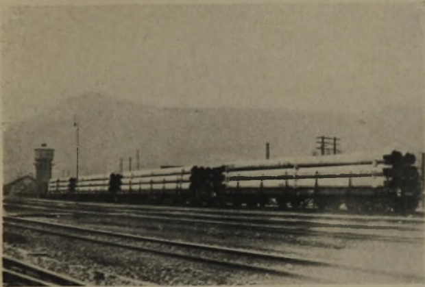
ABB. 6. MODERNER LEITUNGSBAU 700-mm-ROHRE IM BAHNTRANSPORT
