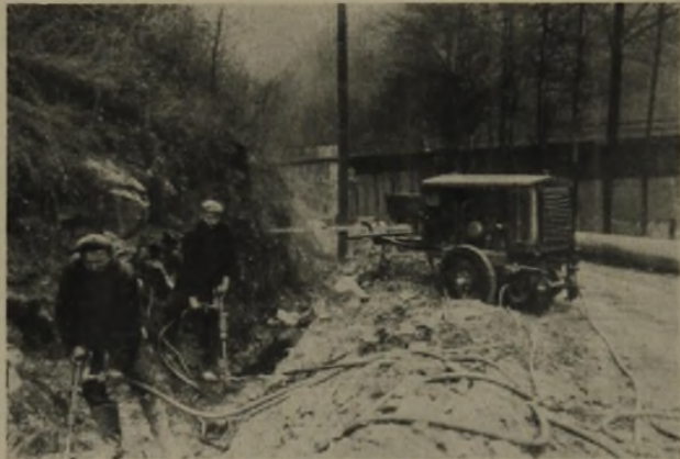
AUSHEBEN DES ROHRGRABENS BEI FELSIGEM UNTERGRUND ABB. 7
