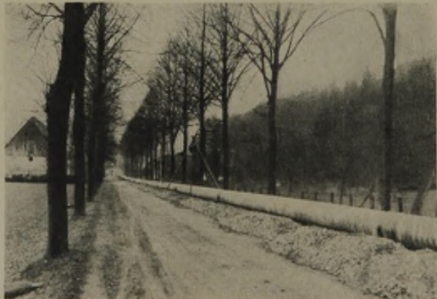
ZUSAMMENGESCHWEISSTE ROHRSTRECKE VOR EINEM DORF ABB. 9
