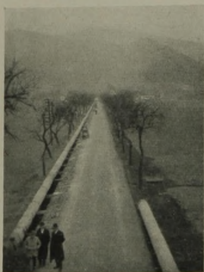
ABB. 10. ROHRSTRECKE AN EINER SERPENTINE
