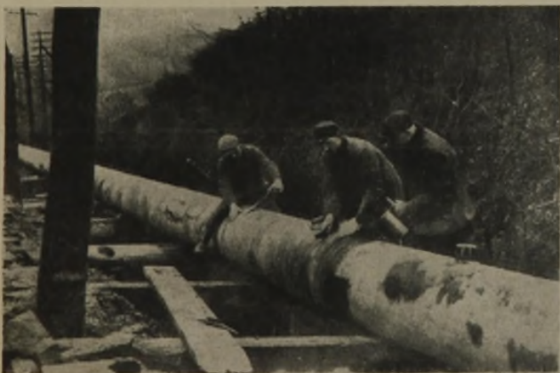
ABB. 8. ABBINDEN UND VERSCHWEISSEN DER ROHRE OBERHALB DER ERDE
