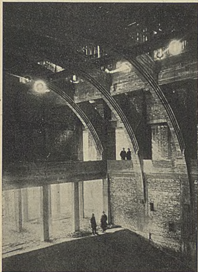
ARCH. JAN WITKIEWICZ. WNĘTRZE AULI PO ZDJĘCIU RUSZTOWAŃ.
