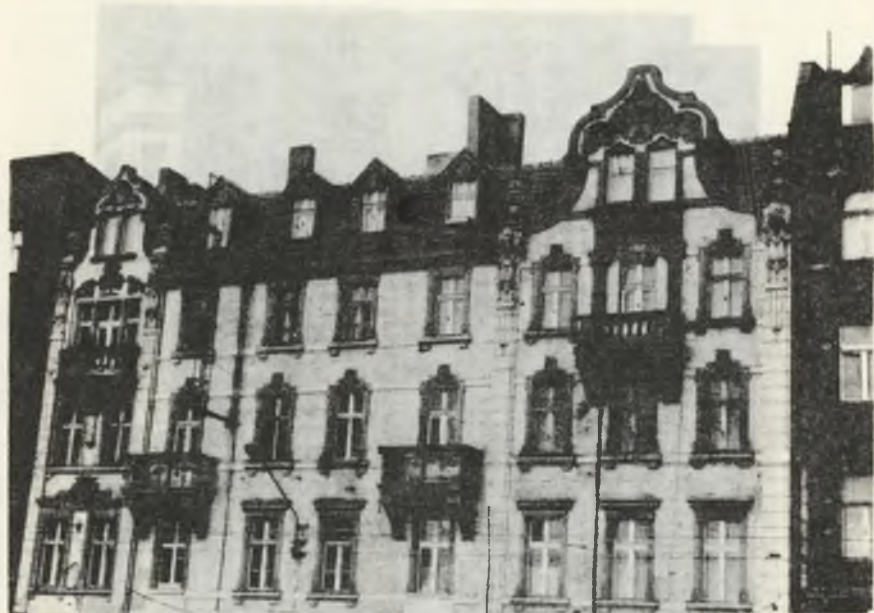
Fot. 2. Ulica 3-go Maja 17; fasada; modernizm + eklektyzm; zbudowana w 1904 r.
