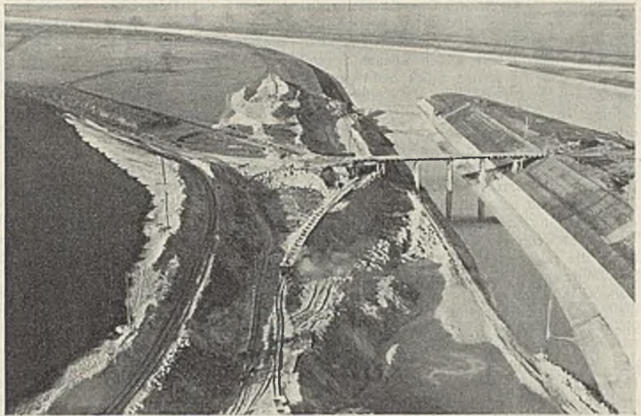
Abb. 20. Klodnitzabsturz. Rutschstelle am Untergraben.
