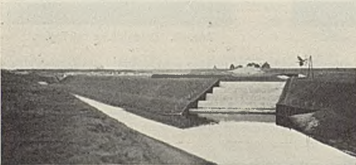
Abb. 16. Kaskadentreppe des Hochwasserentlasters vom Becken II zum Untergraben.
