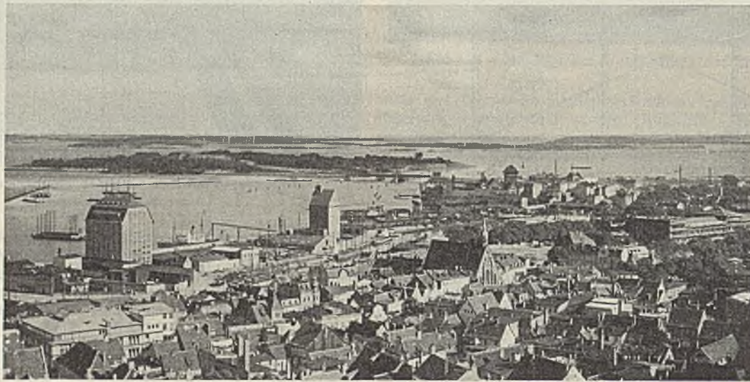
Abb. 30. Ziegelgrabenbrücke in der Landschaft.
