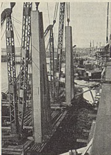
Abb. 22. Portalstiele der Eisenbahnklappe auf dem Transportschiff.
