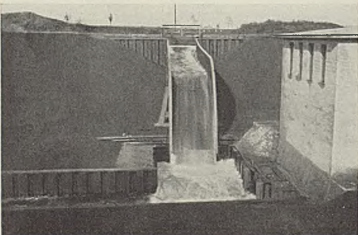
Abb. 17. Einleitungsbauwerk des Patschiner Grabens.
