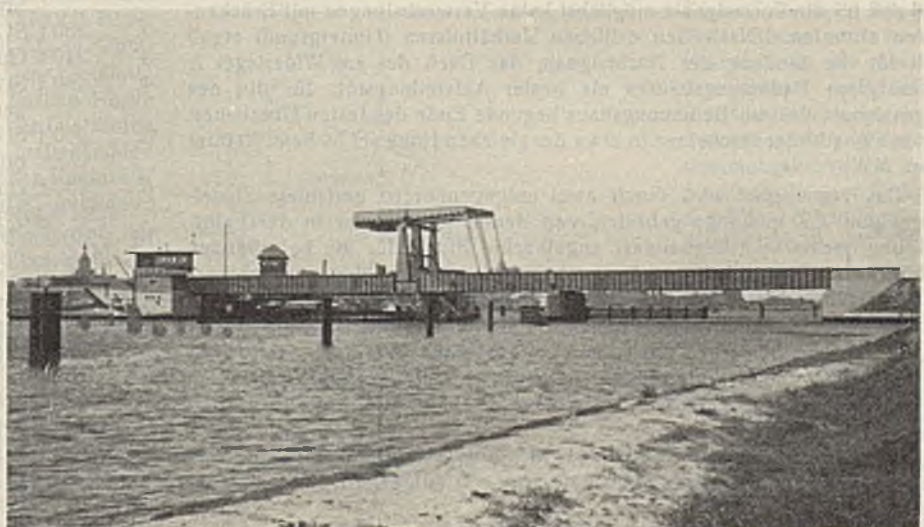
Abb. 31. Gesamtansicht der Brücke.
