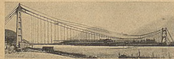
Abb. 4. Montagebild (Kabel fertig, der Versteifungsträger wird vom Kabelkran montiert).
