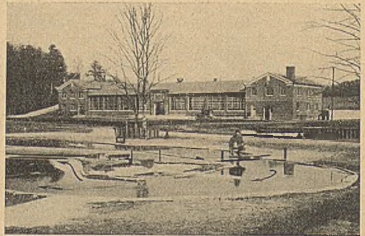
Abb. 5. Die Versuchsanstalt zu Vicksburg. Im Vordergrund ein Freiluftmodell der Slough-Schleife zwischen Meile 59 u. 63 zur Untersuchung der Geröllwanderung in scharfen Flußkrümmungen und der Wirkung eines Abzweigekanal am inneren Ufer.
