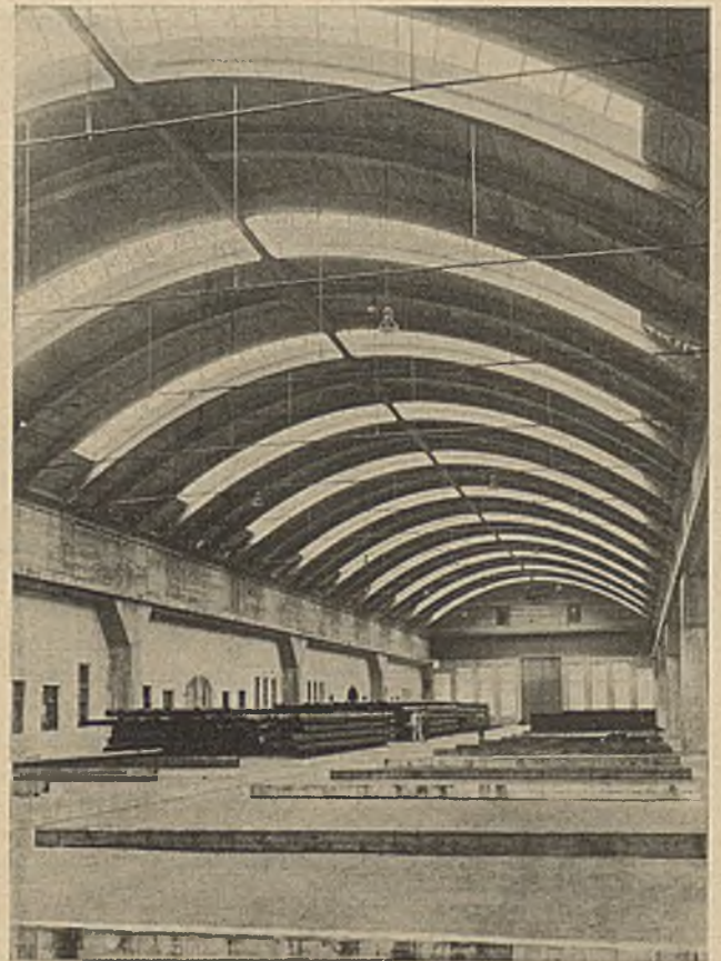
Abb. 17. Inneres der fertigen Halle mit gelagerten Rohren.
