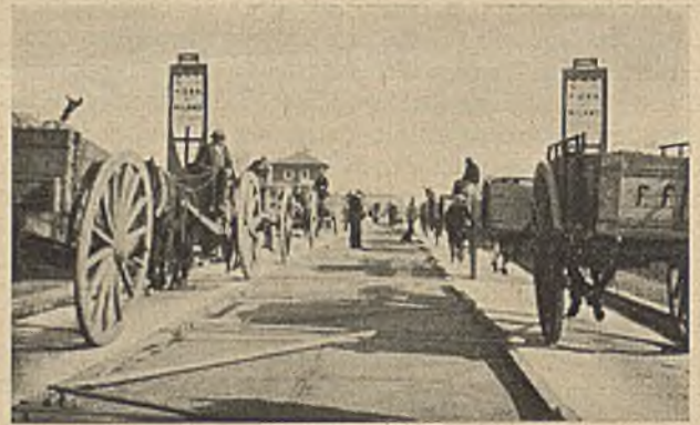
Abb. 2. Fahrversuche auf der Probestraße bei Binasco.
