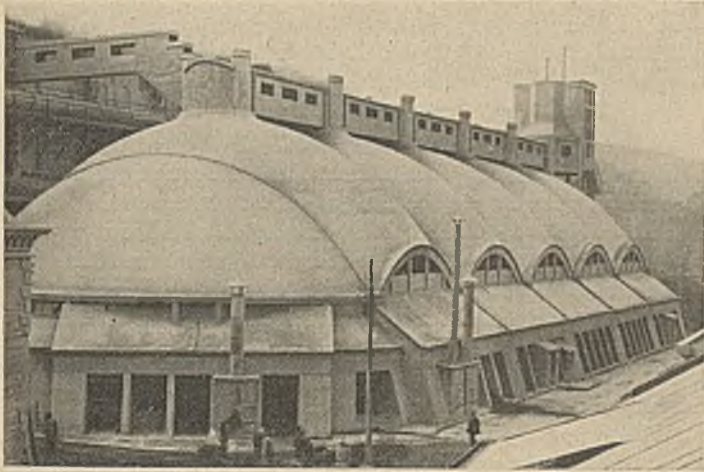
Abb. 7. Klinkerhalle Beocin, Außenbild.
