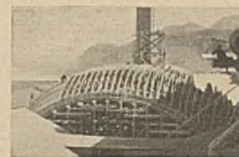
Abb. 10. Klinkerhalle Beocin, Gerüst.
