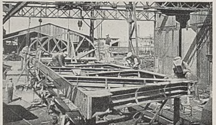
Abb. 10. Verschweißen des Obergurtes.
