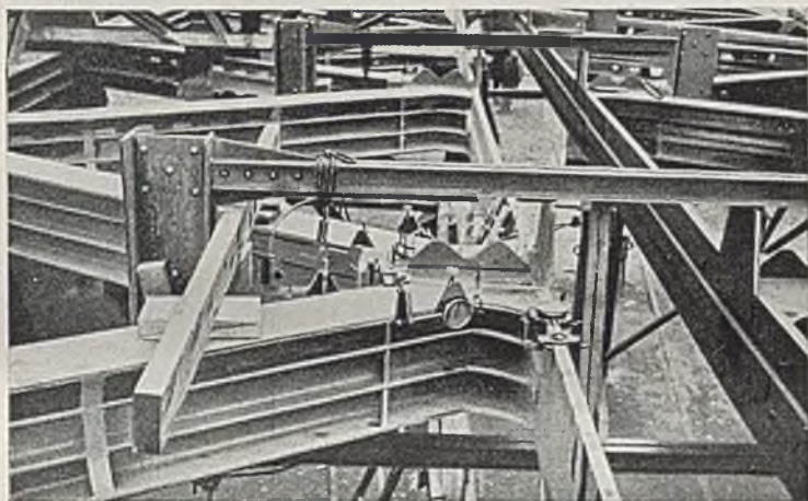
Abb. 12. Messung der Formänderungen bei der Probelastung.
