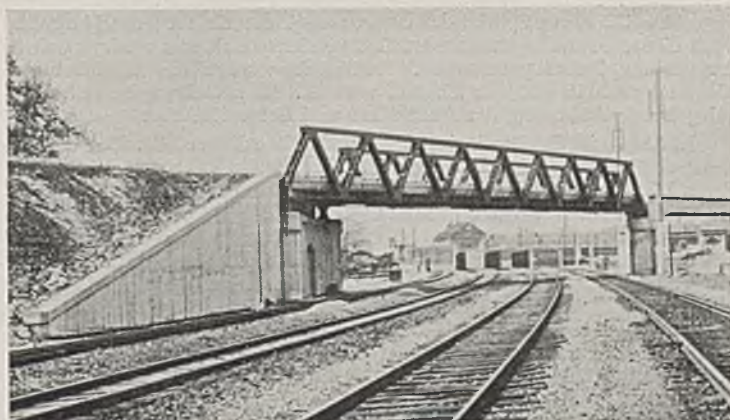
Abb. 1. Ansicht der Brücke.
