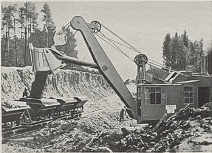
Abb. 8. 1,35-m 3 -Löffelbagger mit angelenktem Löffelstiel, vergrößertem Löffelinhalt und erhöhter Reißkraft (IIA). Aufnahme: Demag.
