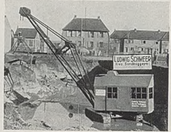
Abb. 13. Greifbagger mit 2 t Tragfähigkeit bei 7 m Ausladung. Aufnahme: Leo Gottwald KG.
