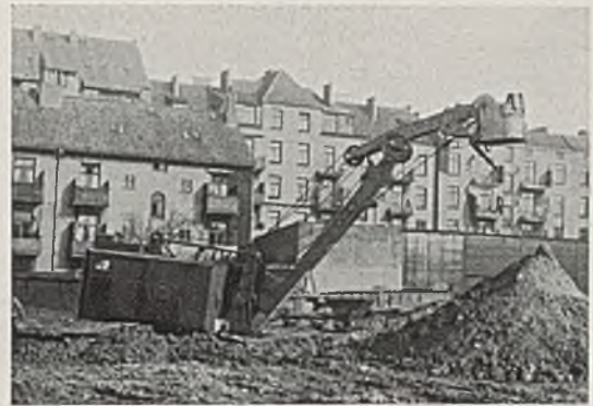
Abb. 10. Löffelbagger mit vergrößerter Reichhöhe. Aufnahme: Menck & Hambrock GmbH.
