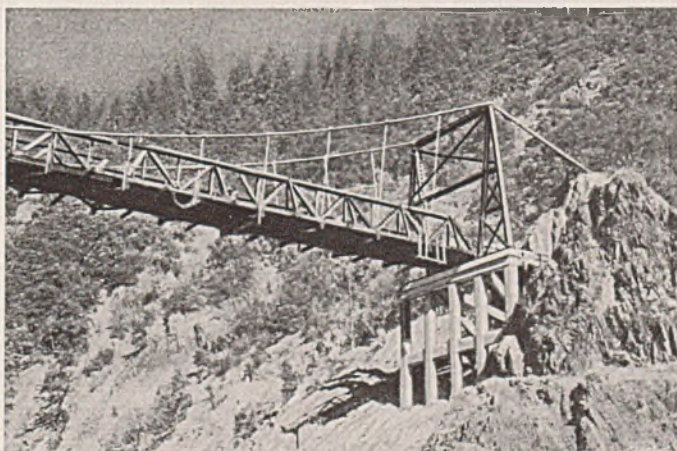
Abb. 4. Die Türme mit dem Eisenbeton-Unterbau.
