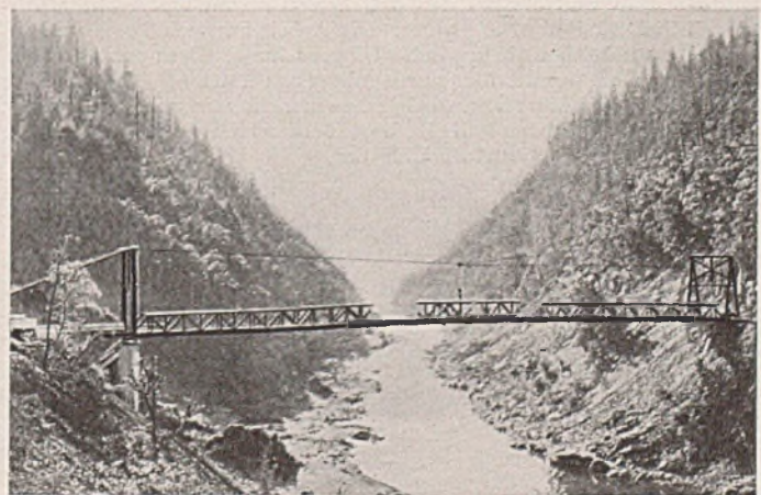
Abb. 5. Ansicht der Brücke während des Einbaues der Versteifungsträger.
