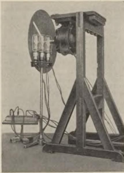
Abb. 4. Glimmlampen hinter der Lochscheibe eines Drehstrommotors zur Erläuterung des Dreiphasenstromes.
