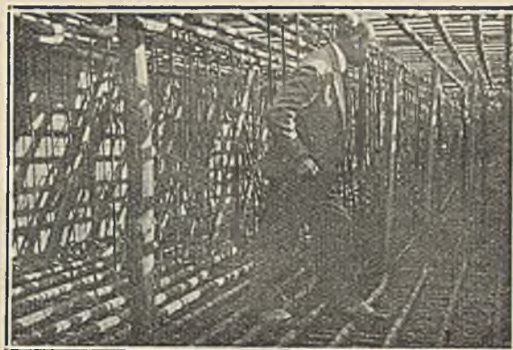
Fragment z budowy Katedry w Katowicach: szkielet żelazny belki fundamentowej pod filarami przed głównym wejściem.
