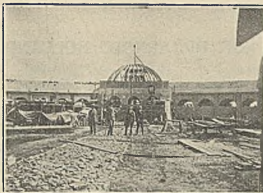
Lwów — Targi Wschodnie — Budowa Pawilonu Centralnego.
