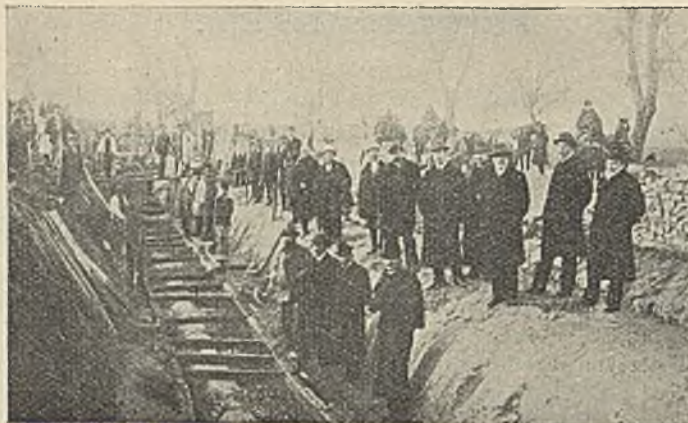
Budowa wodociągów lwowskich.
