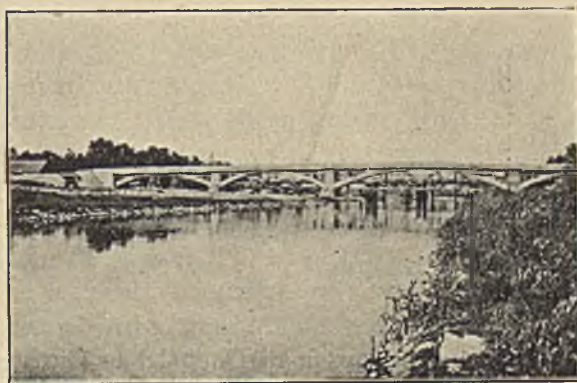
Most na Wiśle pod Nowym Bieruniem na drodze Mysłowice-Oświęcim.
