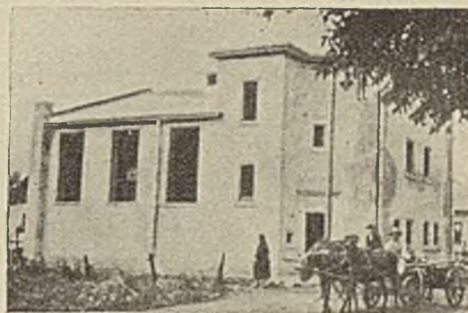
Elektrownia w Śniatynie.
