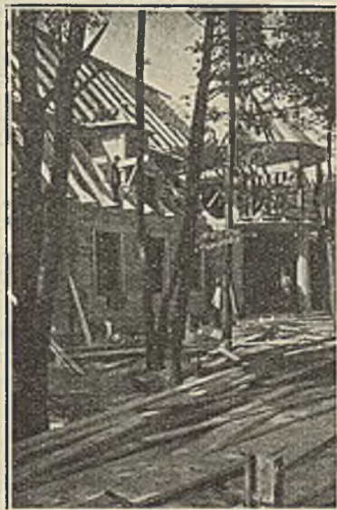
Lwów — Targi Wschodnie — Budowa Pawilonu Ministerstwa Rolnictwa.
