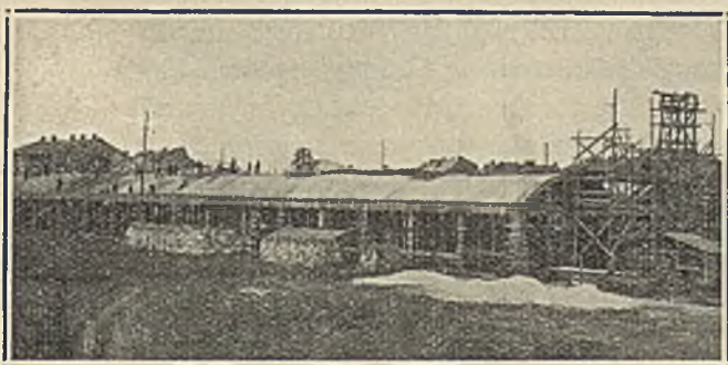
Budowa remizy tramwajowej przy ul. Gródeckiej we Lwowie.
