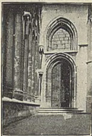
LE PORTAIL SUD-OUEST.
