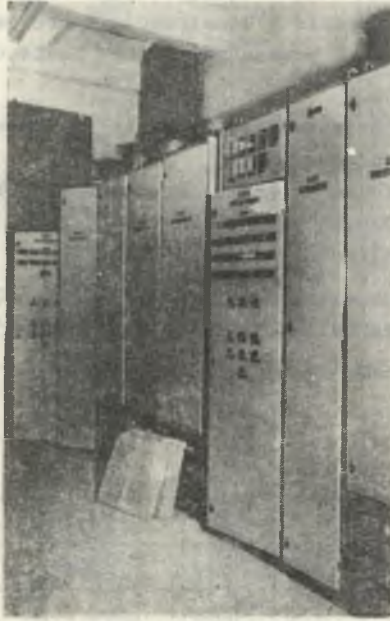
Rys. 4. Szafy przemiennikowe w czasie instalowania
