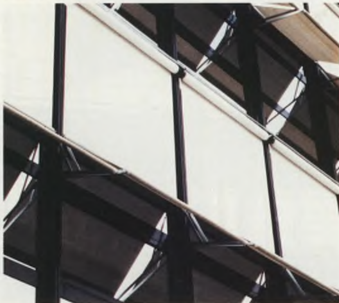
d) detal ruchomych przełon—senso- rów.
