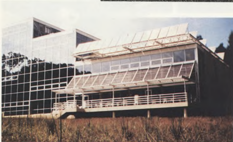
Ryc. 6. Laboratorium badawcze pozyskiwania energii słonecznej w Athens — Atlanta (USA), widok kompleksu.
