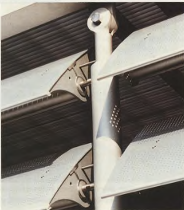
d) widok przesłon od strony ze- wnętrznej
