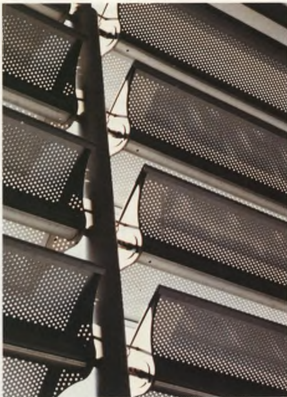
Ryc. 4A. Przesłony na elewacji budynku materialów biurowych w Bolligen (Szwajcaria),
