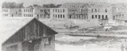
Ryc.6. Zdjęcie z rozbudowy KL Auschwitz I wykonane przez SS jako załącznik do sprawozdań budowlanych. W głębi widoczny nowy zespół 20 bloków więźniarskich tzw. „Erweiterung”. [Archiwum PMO nr ncg. 20995/56]
