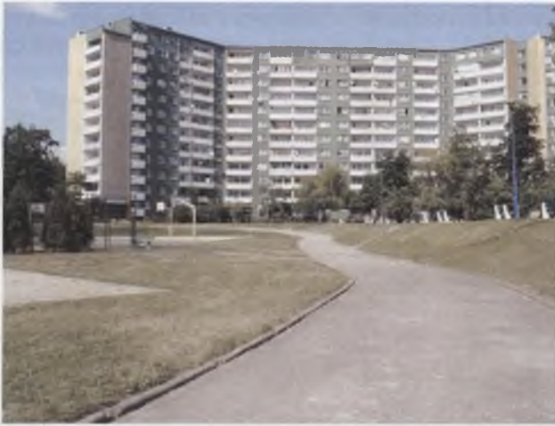
Fot. 5. Duża powierzchnia działki, przestronność terenu, rozległe przestrzenie trawiaste. (Osiedle „Na Polance” we Wrocławiu) Autorzy: Fabiana Owczarek, Aleksandra Napiórkowska Pic. 5. Large building plot area, spaciousness of area, extensive grassy spaces (settlement “Na Polance” Wrocław)
