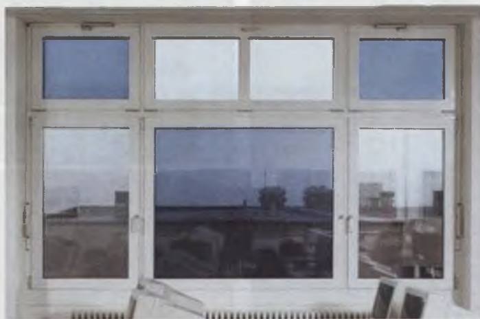
Rys. 5. Przykład szklenia elektrochromowego. Źródło: www.glasstec.de/cipp/md_glasstec [dostęp: 14.04.2013].
