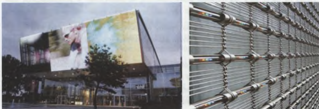
Rys. 4. Pierwsza w pełni transparentna fasada zaprojektowana w 2001 r., obok kurtyna LED Źródło: http://www.ag4.de [dostęp: 14.04.2013].
