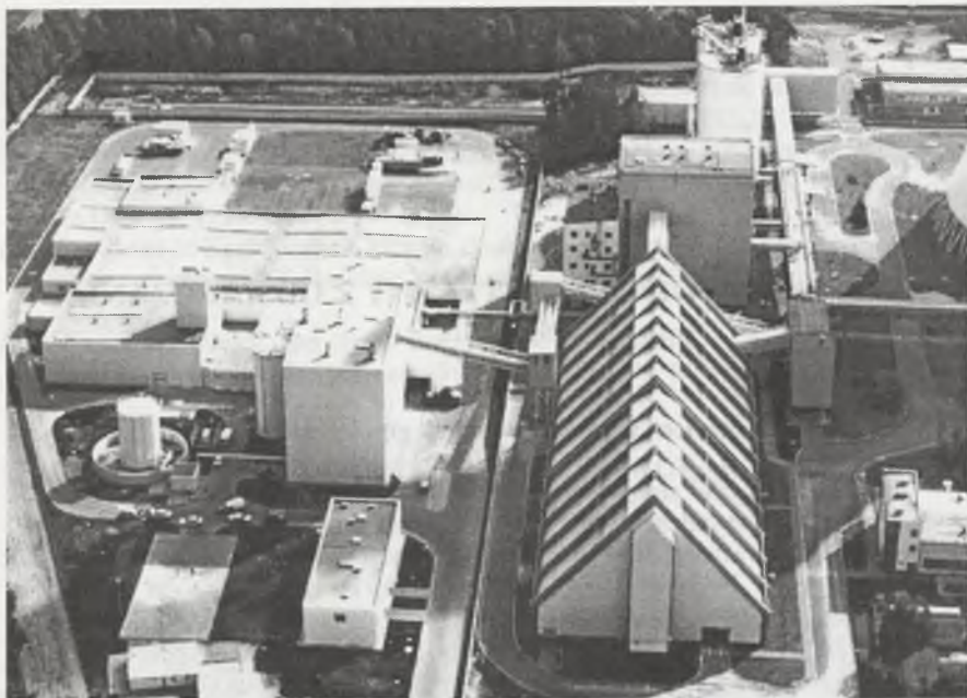
Fot. 1 Ogólny widok firmy KNAUF - zakładu produkcji suchych mieszanek tynkowych w Jaworznie
