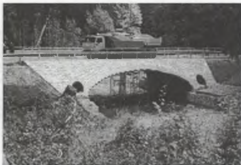
Rys. 3. Widok z boku na most podczas prowadzenia badań doświadczalnych (III schemat obciążeń) Fig. 3. Side view on the bridge during the conducted research (the field load tests) – III scheme of load
