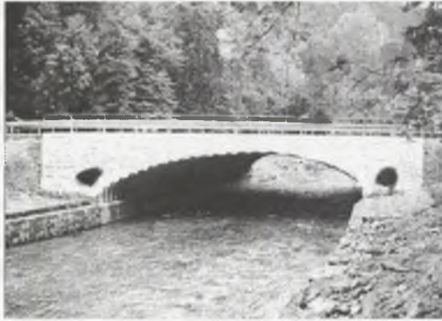
Rys. 1. Widok z boku na most wykonany ze stalowych blach falistych położony w Polanicy Zdroju Fig. 1. Side view on the bridge made of the steel corrugated plates located in Polanica Zdrój
