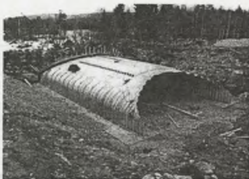
Rys. 2. Widok z góry na zmontowaną stalową powłokę mostu przed zasypywaniem Fig. 2. Top view on the assembled steel bridge shell before backfilling
