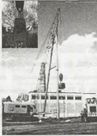
Rys.1. Urządzenie DYZAG wraz z ubijakiem [4] Fig. 1. DYZAG facility including rammer [4]
