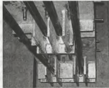
Fot. 2. Zakotwienie bierne Pic. 2. Passive anchorage
