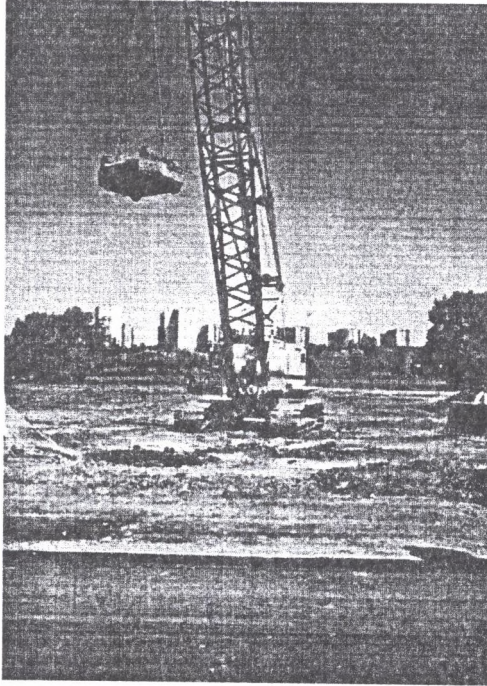
Rys.1. Zagęszczanie materiału skalnego za pomocą płyty stalowej Fig.1. Consolidation rock materials with the assistance steel panel
