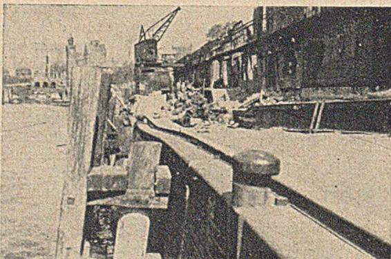
Abb. 3. Zerstörte Kaimauer am Johannishöllwerk. — Setzung der Kaimauer durch Einrüttlung der Pfähle und Bodenauflockerung (Fall 3).
