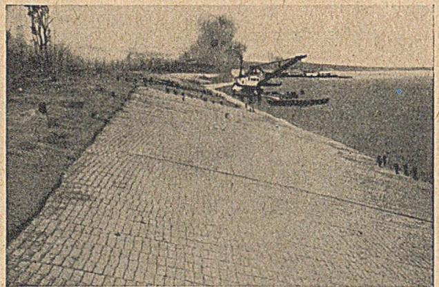
Abb. 2. Mit Betonmatten abgedeckte Böschung.
