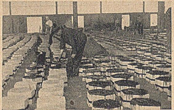
Abb. 16. Betonsteinpflaster am Kaischuppen 75. — Aufbringen des Oberflächenanstrichs.
