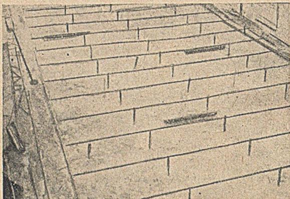
Abb. 18. Kühlrohrharfe (Aufnahme eines Versuchsblocks).
