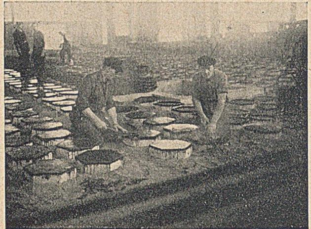
Abb. 3. Sechseckplatten. Aufbringen des Heißasphaltanstriches.
