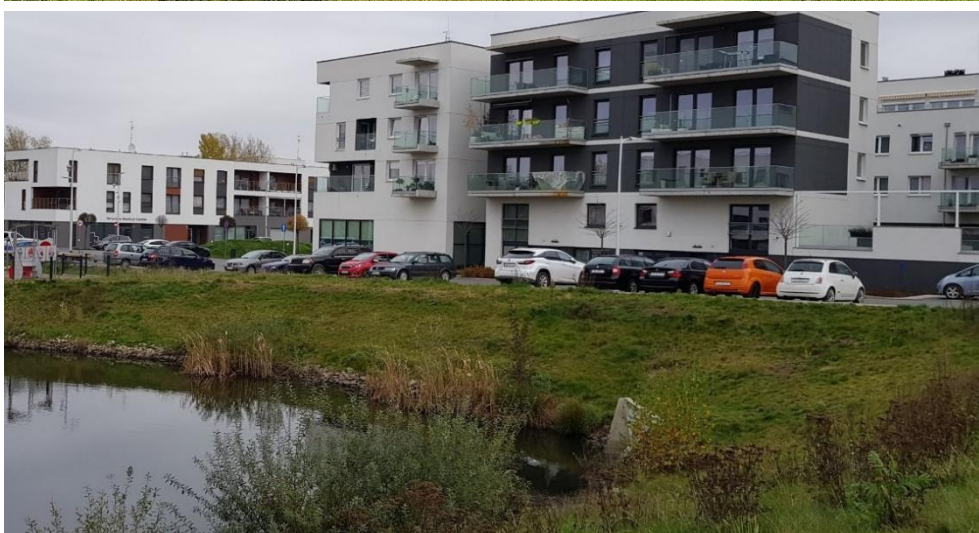
Il. 2.21. Przykłady zabudowy wielorodzinnej wraz z terenami zieleni i obszarami małej retencji; zbiornik wodny w zespole Nowe Żerniki, Wrocław oraz dół chłonny (na pierwszym planie); Prosek Park, Praga
