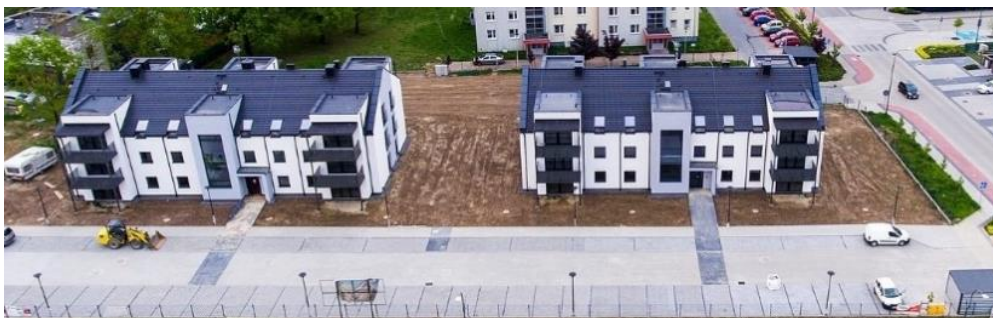
Il. 3.7. Knurów Wiosenna: roboczy bryłowy model fizyczny koncepcji urbanistycznej oraz zdjęcie z realizacji
