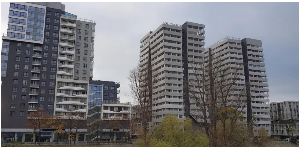
Il. 1.2. Wybrane tendencje w realizacjach mieszkaniowych w Polsce: budynki o bardzo dużej intensywności (Atal Towers, Wrocław)
