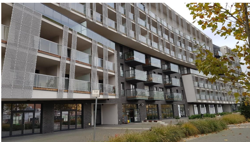
II. 2.12. Usługi na parterach cofnięte względem kondygnacji wyższych; osiedle Nowe Żerniki, Wrocław oraz Atal Towers, Wrocław Źródło: fot. T. Bradecki
