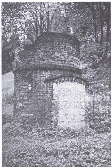
Rys. 7. Widok komina wentylacyjnego Fig. 7. View of the ventilation chimney
