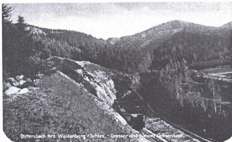
Rys. 1. Widok na Mały Wołowiec i budowę drugiej komory tunelu. Pocztówka z roku 1911 Fig. 1. View on Mały Wołowiec mountain, and construction of second tube of the tunnel. Postcard 1911
