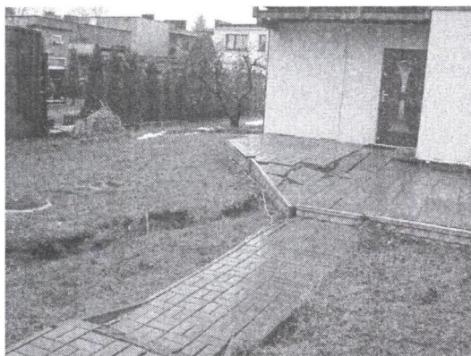
Rys. 4. Widok progu terenowego Fig. 4. View of the terrain threshold
